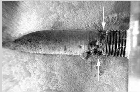
Seisovan jäähdytysveden aiheuttamat korroosioauriot kanavassa.
